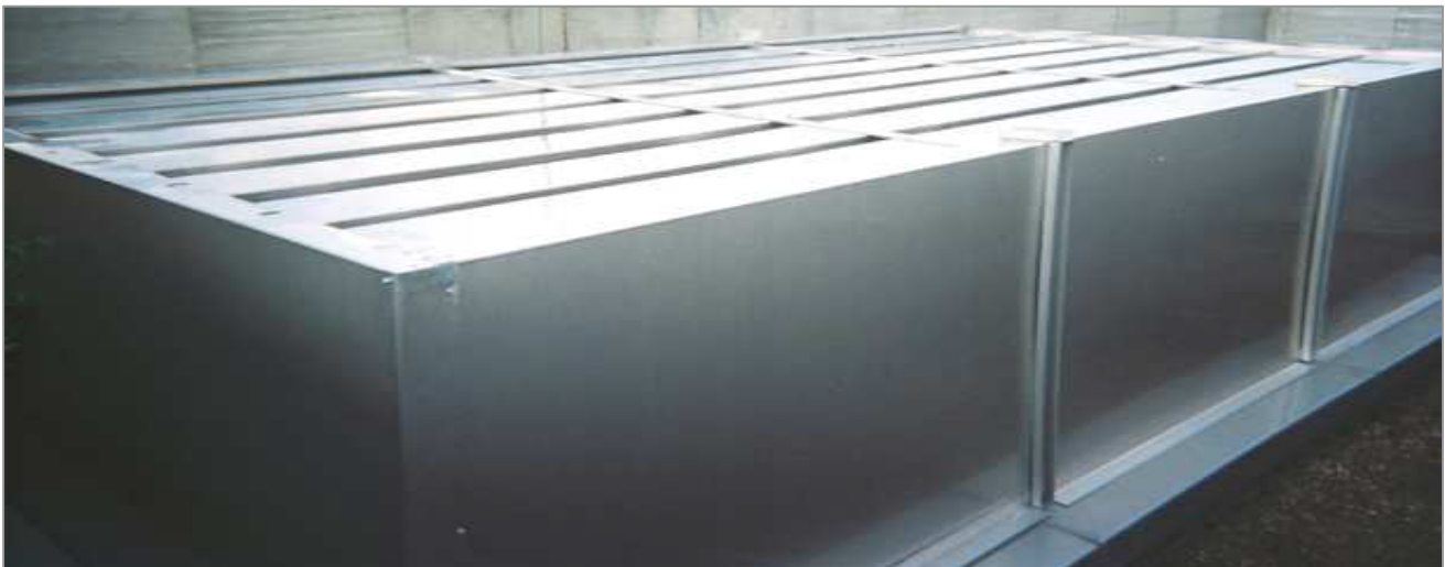
Silencieux inox sur tour de refroidissement
